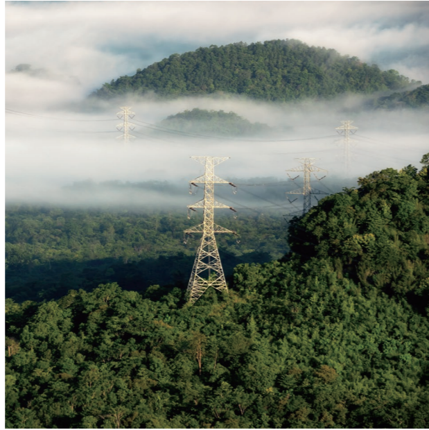
国家电网项目
