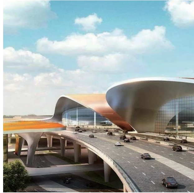
北京新机场东航基地项目
