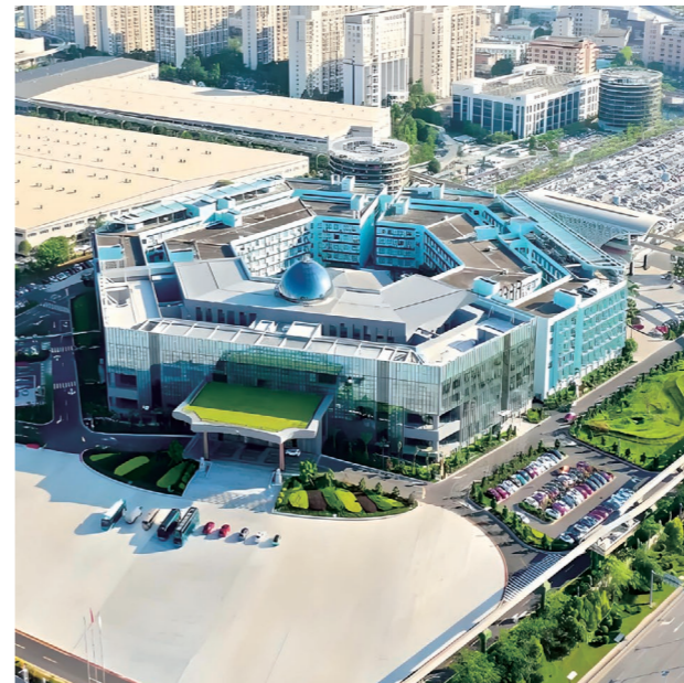
比亚迪深汕1号厂房UPS配电项目
