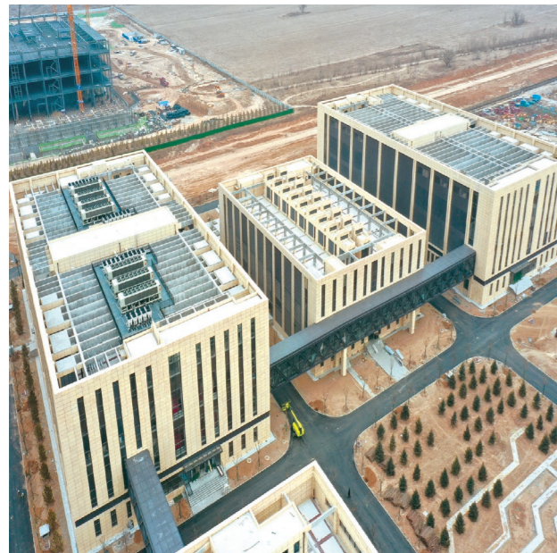
某大型国有银行总行核心数据中心项目
