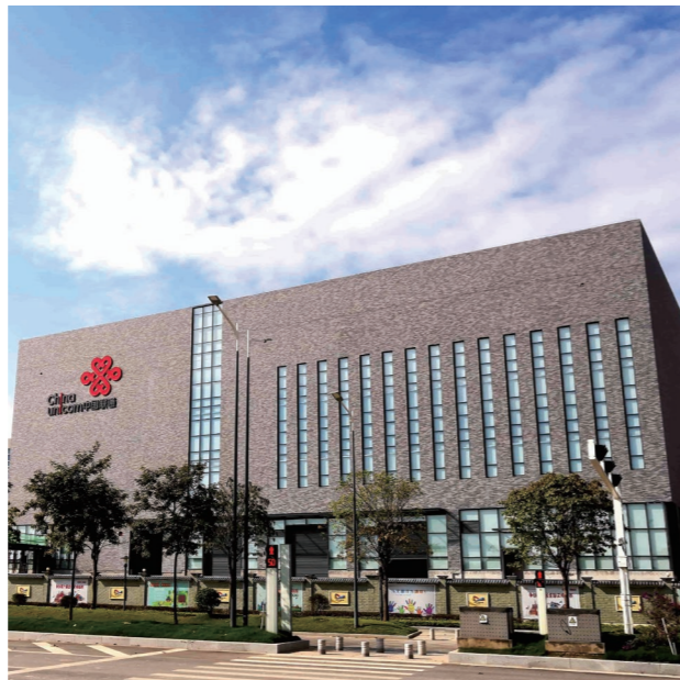
中国联通云数据中心项目
